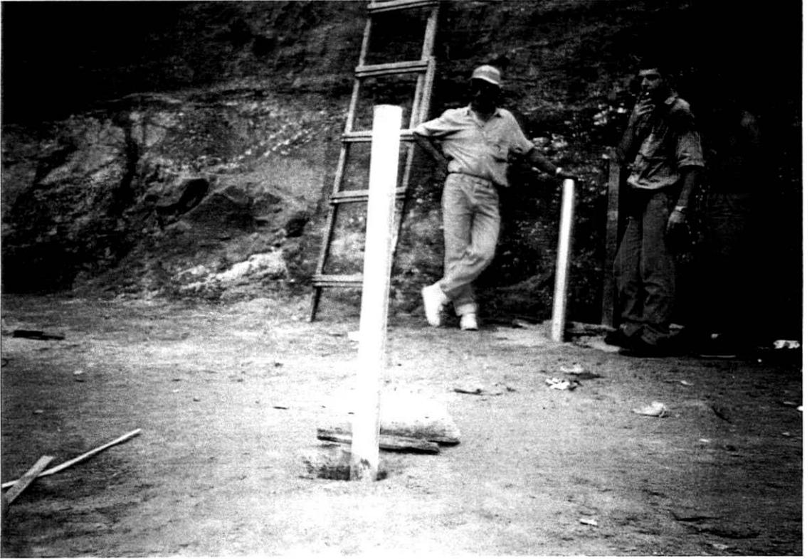
FOTO Nº 11 - Instalação dos inclinômetros.
