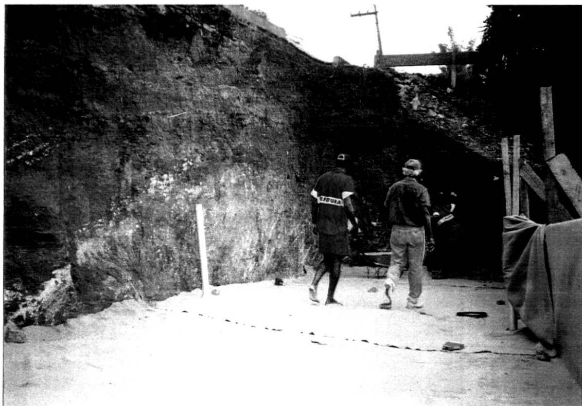
FOTO N° 12 - Instalação da 1ª camada de reforço.
