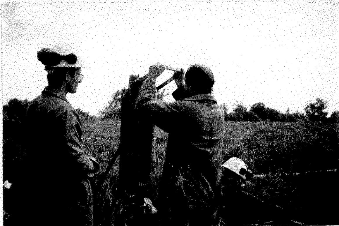
Foto 21 - Retirada da parte superior amolgada.
