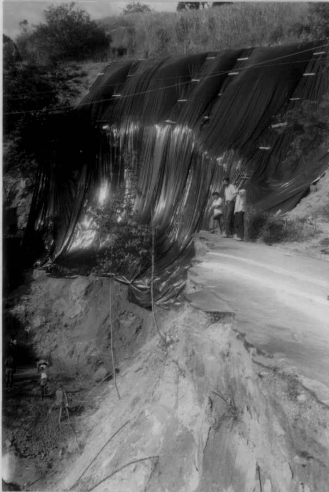
**FOTO VI.5 TALUDE COBERTO COM TOLDÔ DE PLÁSTICO - ZONA B**
