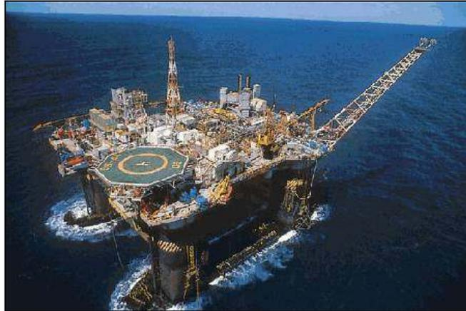
Figura 2. Plataforma semi-submersível.
