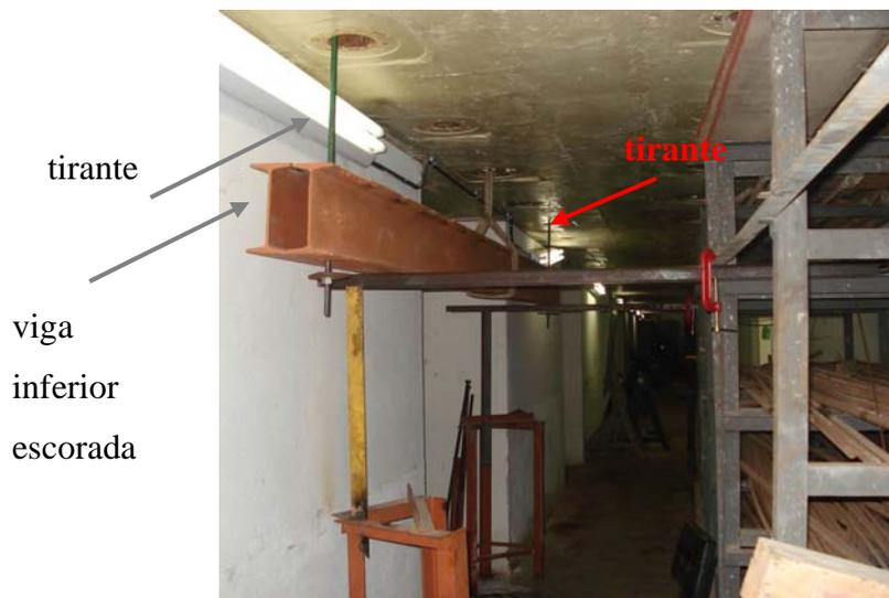
Figura 6-16 – Subsolo da placa de reação do Labest: viga inferior e tirantes.
