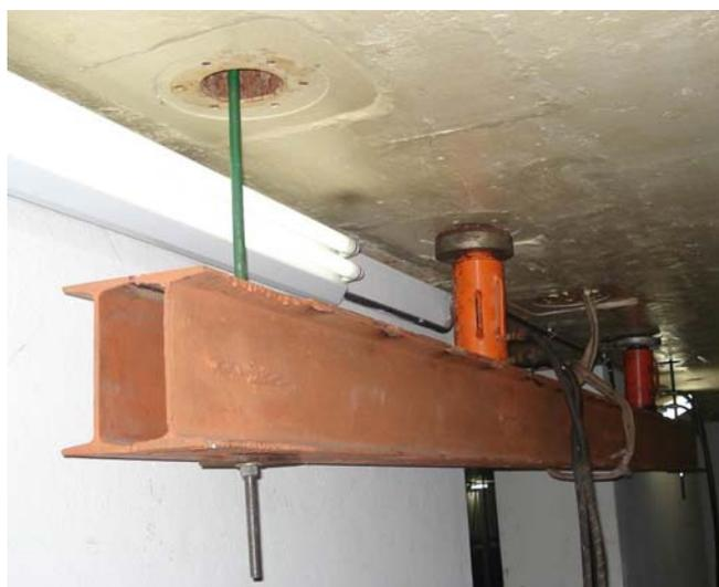
Figura 6-17 – Macacos hidráulicos posicionados na viga inferior.
