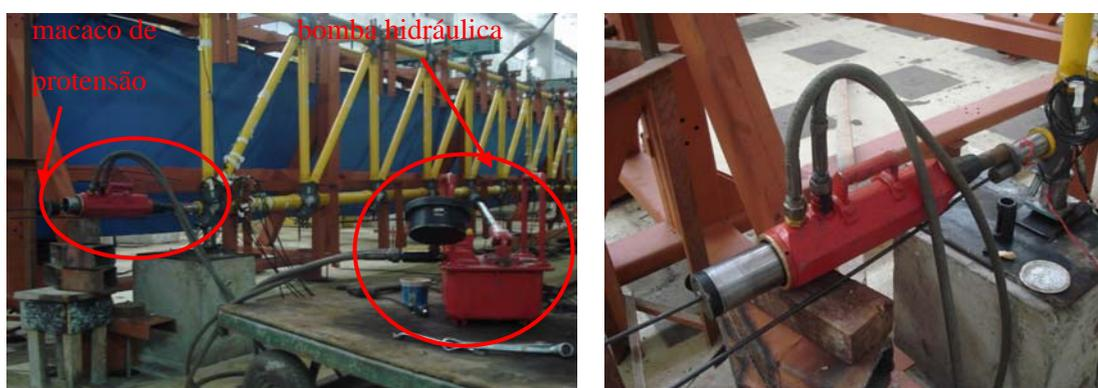
Figura 6-12 – Protensão do banzo inferior da treliça sobre os apoios.
