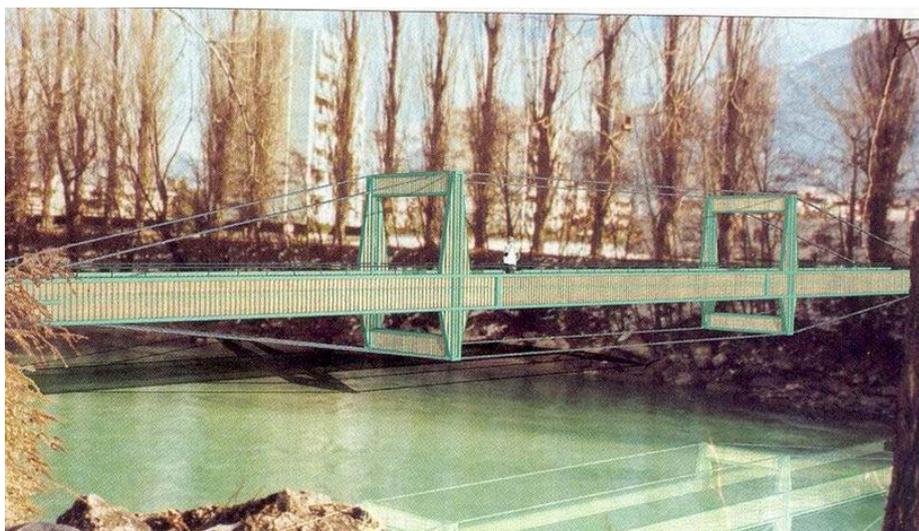
Figura 1-13 – Passarela estaiada e com viga armada, Suíça [22]
