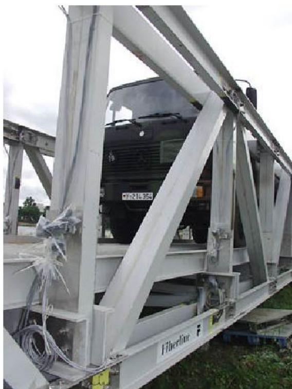
Figura 1-9 – Detalhe do apoio do tabuleiro sobre as transversinas e das ligações das transversinas à treliça da ponte protótipo da RWTH-Aachen [26].
