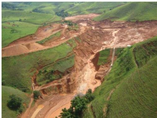
**Figura 1.7 – Barragem de Rejeito da Bauxita, após o seu rompimento (REDE ATIVIDADE, 2013)**
