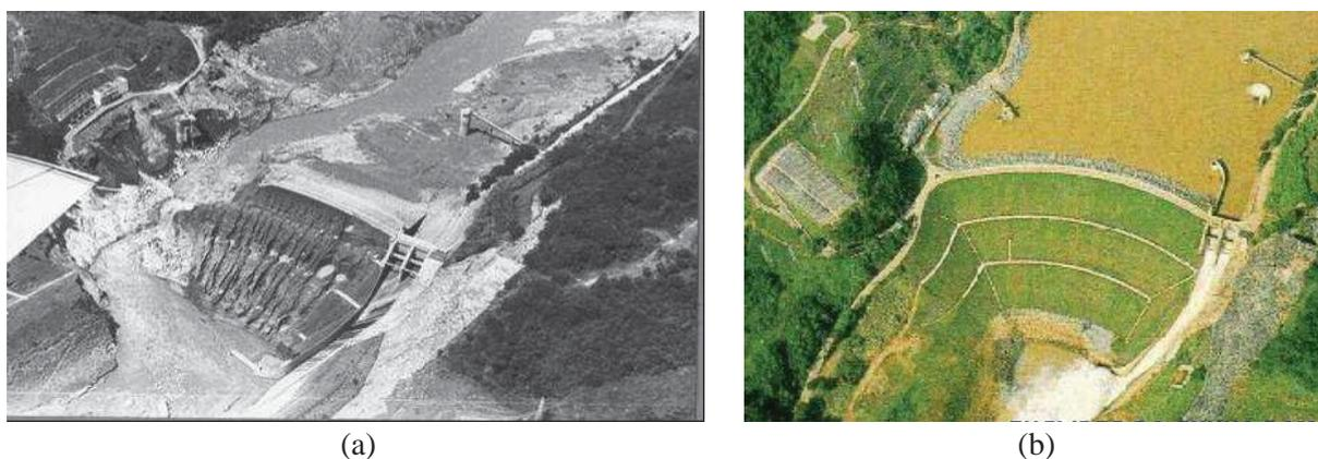
**Figura 1.5 – Barragem de Euclides da Cunha: (a) após o rompimento (CBDB, 1982); e (b) após a reconstrução (CBDB, 2011)**
