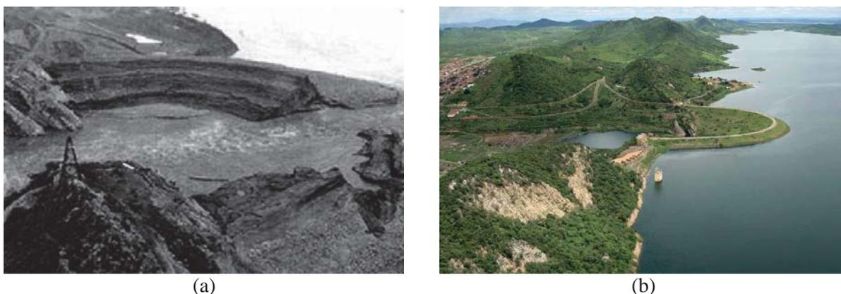
**Figura 1.4 – Barragem de Orós: (a) após o rompimento; e (b) após a reconstrução (CBDB, 2011)**
