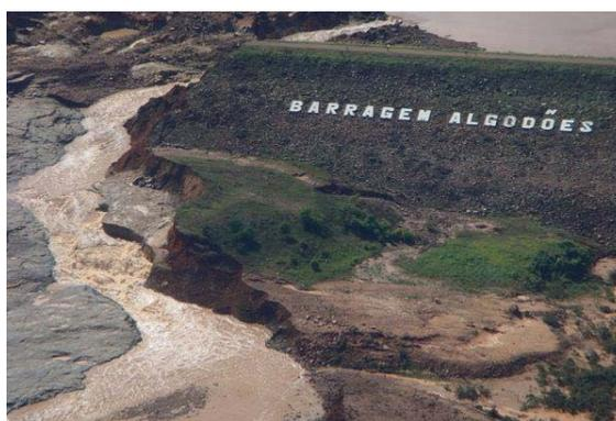
**Figura 1.9 – Barragem de Algodões I após a ruptura (O GLOBO, 2012)**
